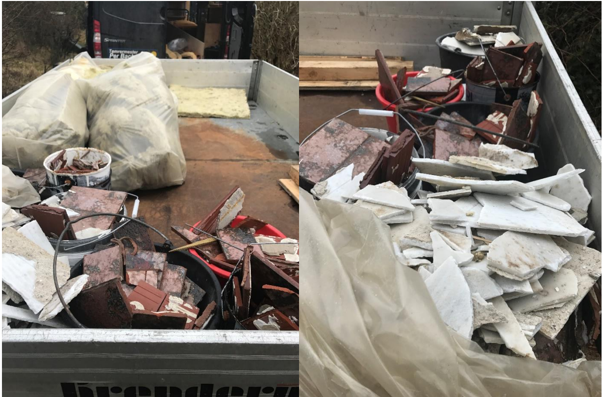
Billede 4: Et typisk oprydningslæs, hvor der er sorteret til hård deponi i spande, isolering er kommet i poser og der ligger en lille smule træ. I læs som disse vil der sjældnere gemme sig materialer, der kan genbruges.
