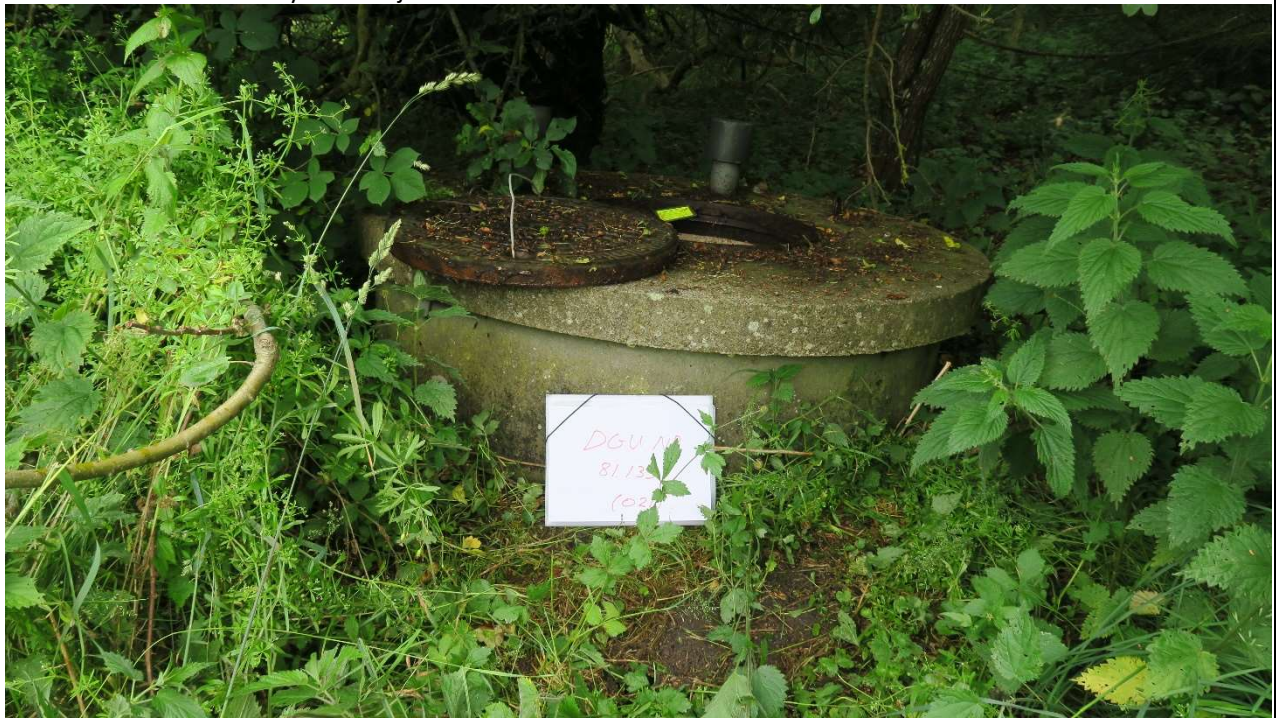
Foto 43: Boring DGU. Nr. 81.135 (O21) er placeret i kanten af en lysning. Billedet er taget fra øst mod vest.
