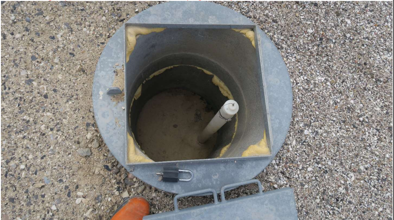
Foto 36: Boring XX er udført i Ø63 filterrør, placeret i Ø600 betonrør med støbt bund og 50 cm firkantet galvaniseret låg.
