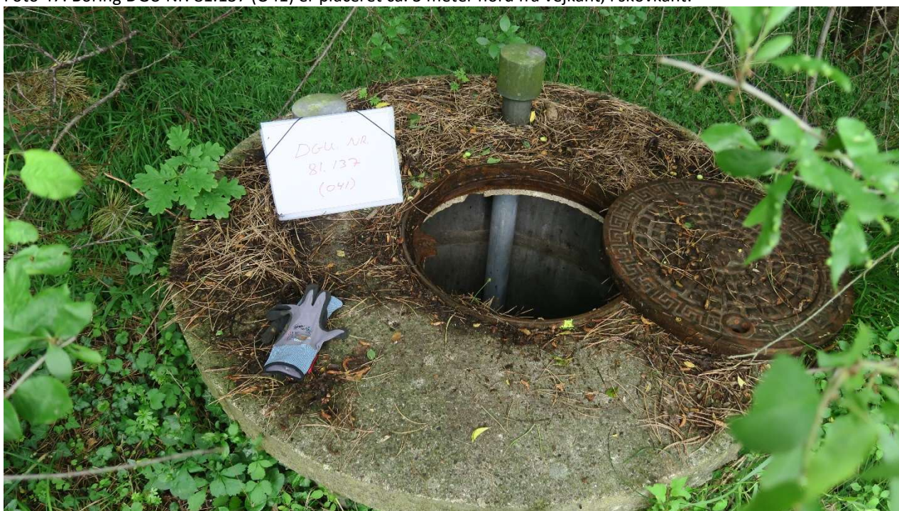
Foto 48: Boring DGU Nr. 81.137 (O41) er udført i Ø125 filterrør, placeret i Ø1500 betonringe med støbt bund og betonlåg med Ø60 mandehul.
