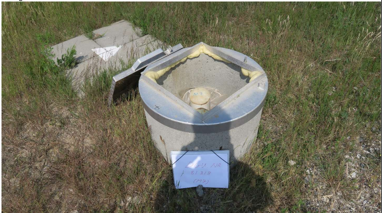
Foto 10: Boring DGU. Nr. 81.318 (M7) er udført i Ø125 filterrør, placeret i et Ø60 betonrør med støbt bund, med 50 cm kvadratisk metallåg.
