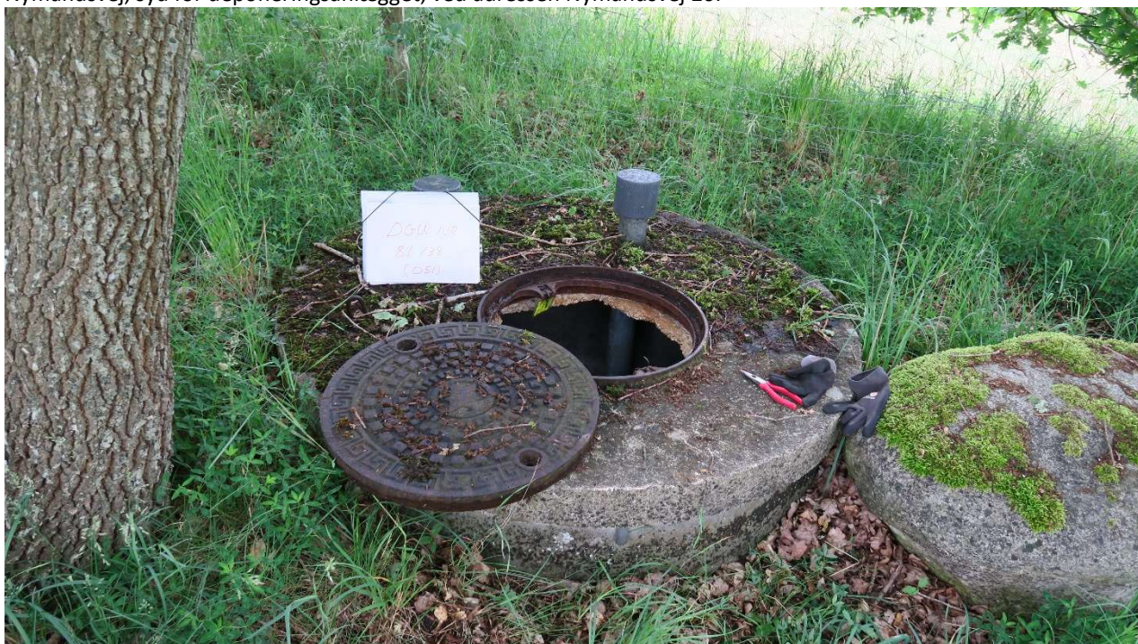
Foto 49: Boring DGU. Nr. 81.138 (O51) er placeret under et træ, ved indkørslen til adressen Nymandsvej 20.
