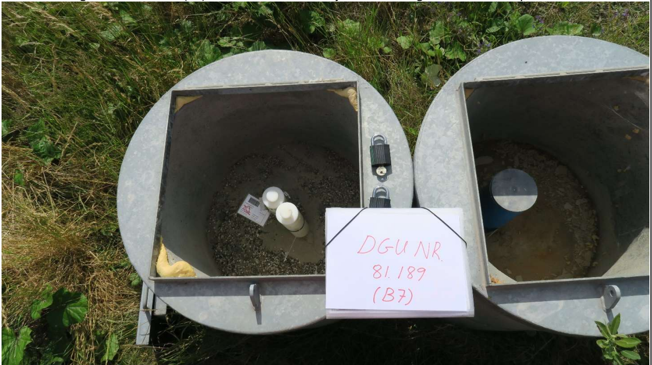
Foto 30: Boring DGU. Nr. 81.189 (B7) har 3 indtag, placeret i 2 stk. Ø600 betonrør med støbt bund og 50 cm firkantet galvaniseret låg. Indtag 1 er Ø125. Indtag 2 og indtag 3 er Ø63.
