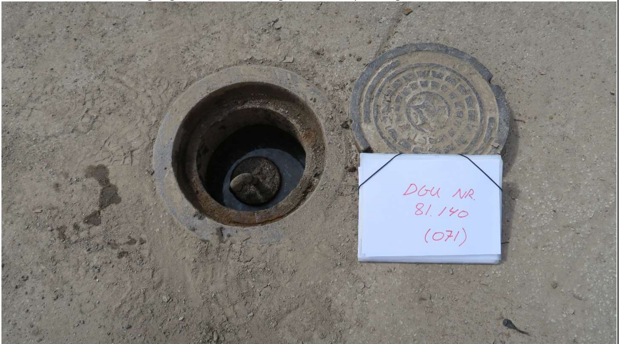
Foto 54: Boring DGU Nr. 81.140 (O71) er udført i Ø125 filterrør, lukket med aftagelig top med rør. BEMÆRK værktøj nødvendigt for at løfte dæksel.
