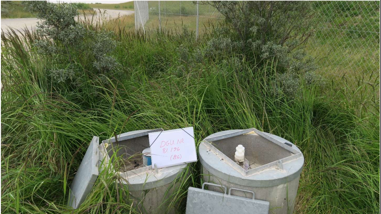
Foto 27: Boring DGU. Nr. 81.196 (B6) er placeret langs den sydlige adgangsvej til etape III, øst for indhegningen til etape II.
