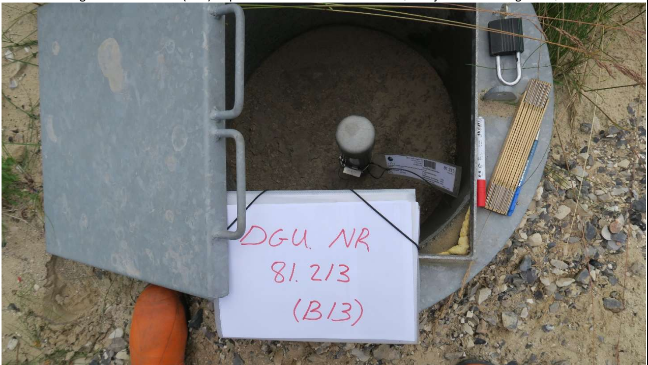
Foto 38: Boring DGU. Nr. 81.213 (B13) er udført i Ø63 filterrør, placeret i Ø600 betonrør med støbt bund og 50 cm firkantet galvaniseret låg. Kørevej lige til boring.
