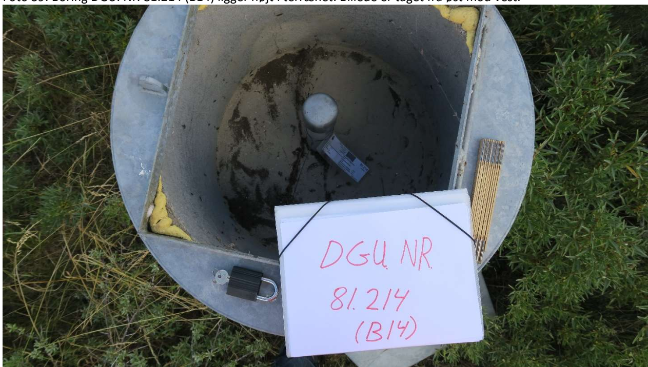
Foto 40: Boring DGU. Nr. 81.214 (B14) er udført i Ø63 filterrør, placeret i Ø600 betonrør med støbt bund og 50 cm firkantet galvaniseret låg.
