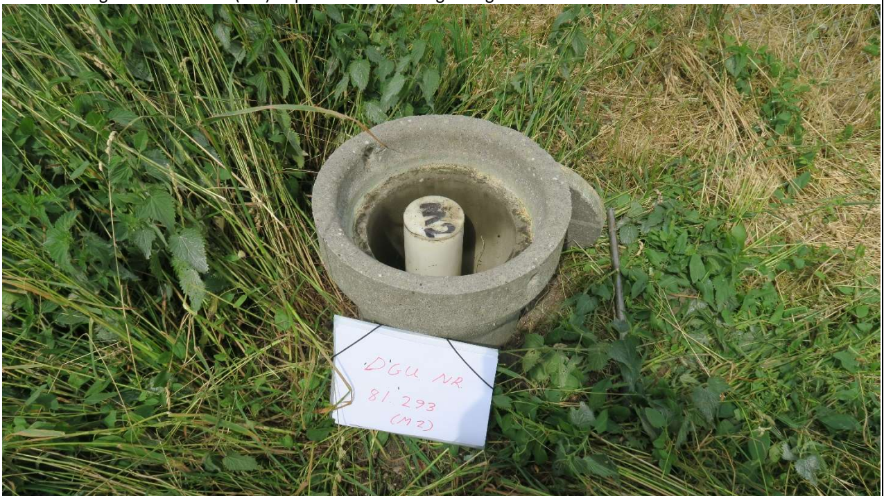
Foto 4: Boring DGU. Nr. 81.293 (M2) er udført i Ø125 filterrør, placeret i et Ø300 mufferrør, med betonglåg og låsestang.
